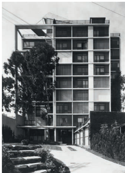
Edificio Los Eucaliptos, Juan Kurchan et Jorge Ferrari Harday, architectes, Buenos Aires, 1944 © Ferrari Hardoy Archive
